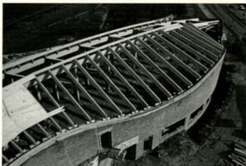
Konstrukcja dachu Centrum manggha w trakcie realizacji / Roof structure of the manggha Centre under construction, 1994
