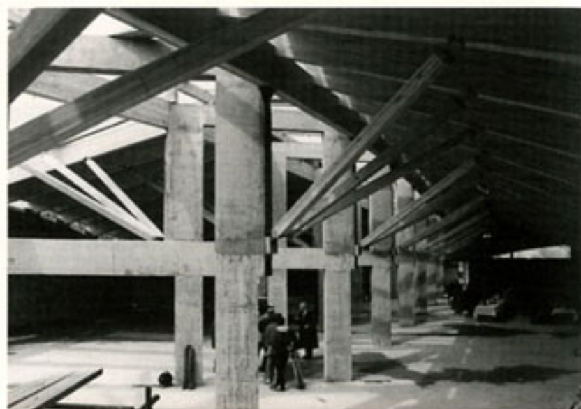
Hall Centrum manggha w trakcie realizacji / Hall under construction, 1994
