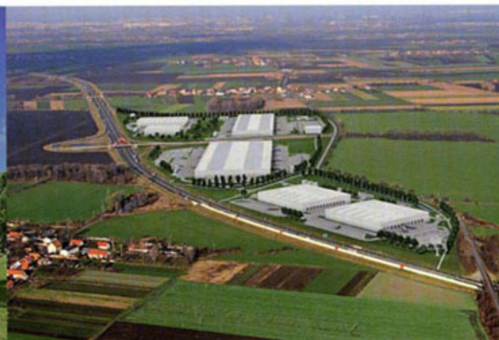
Zespół obiektów magazynowo-biurowych dla firmy SKALSKI w Wojkowicach k. Wrocławia, pow. zabudowy: 132 064,00 m 2
