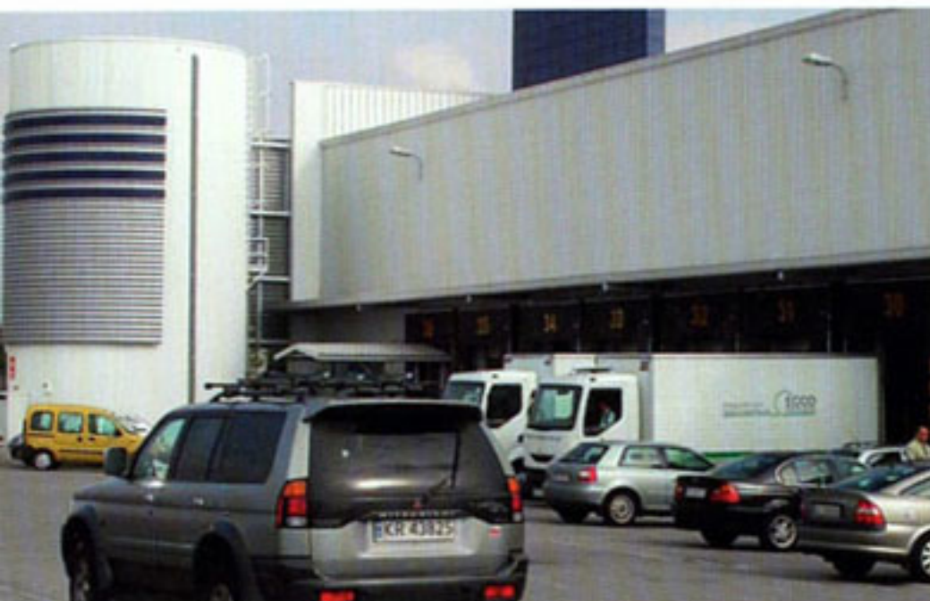
Hala magazynowo-biurowa dla firmy BIK SA w Ożarowie Mazowieckim, pow. użytkowa: 13 312,63 m 2
