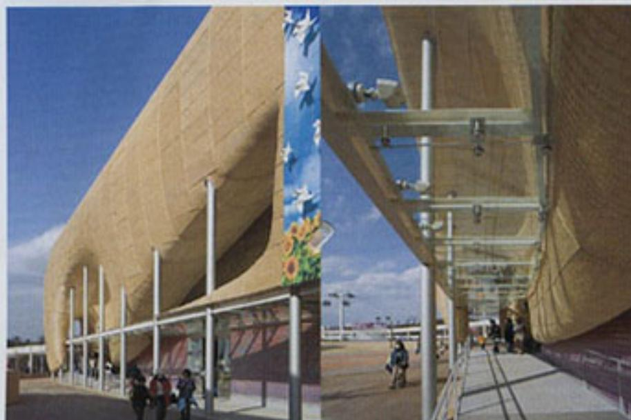
コンピュータの3D技術によって生まれた外形は、ポーランドの伝統的な素材ウイッカーメッシュにより覆われている。
